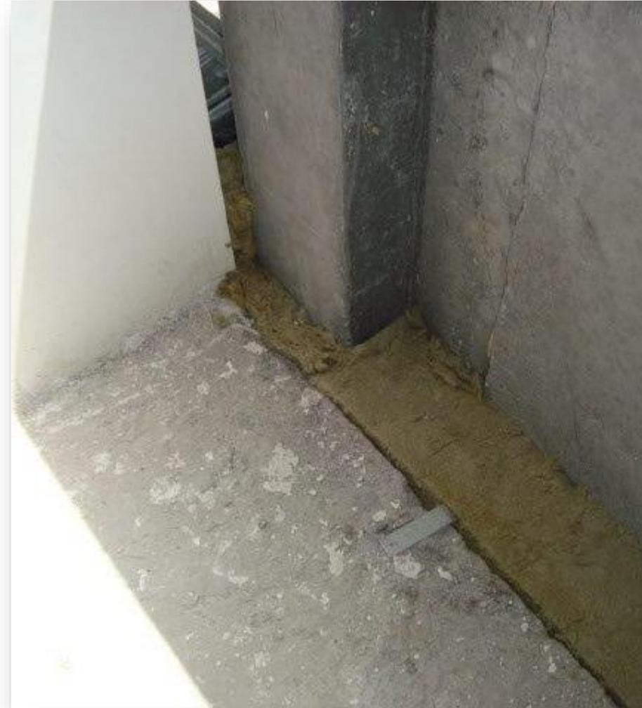
*Fig 17: "FIRE STOP" executado em lã de rocha.*
