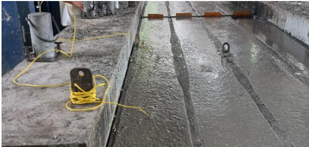
Instalação dos Termopares
