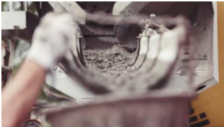
Lançamento do concreto
